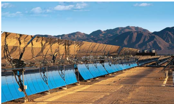
► System nadążania Rexroth: umożliwia „nadążanie za słońcem” długich do 150 m rynien parabolicznych
