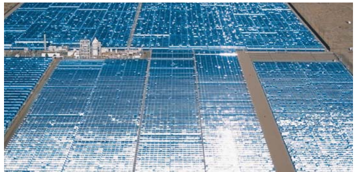
► Elektrownia słoneczna: dla instalacji o mocy elektrycznej 50 MW wymagany jest obszar około dwóch kilometrów kwadratowych
