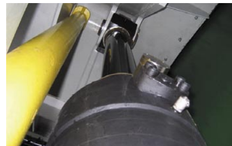
Rys. 7. Cylinder napędu kłapy jazu we Włocławku
