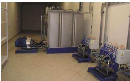
Rys. 5. Jaz „Kozielno” - zbiornik hydrauliczny z zespołem
